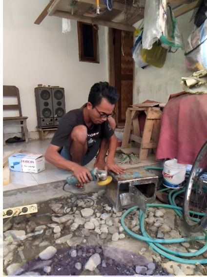
Pembuatan Tungku pembakaran Sampah
