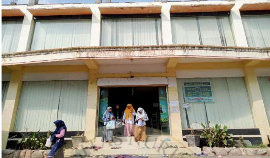
Gambar 1 Gedung Koperasi Induk Wilayah Az-Zainiyah
