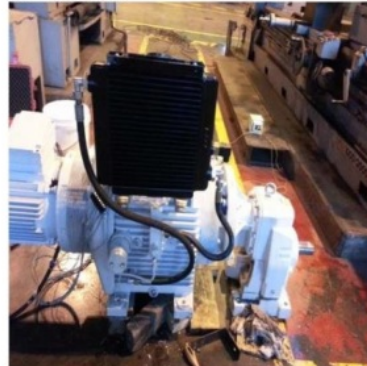
Gambar 4.2 Penambahan oil cooler pada speed variator
