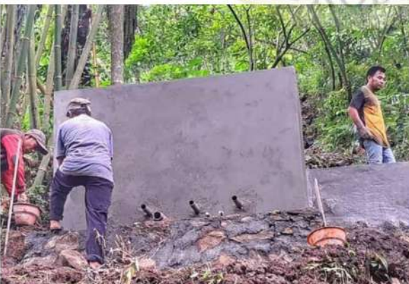
Pembangunan tandon air di Krucil
